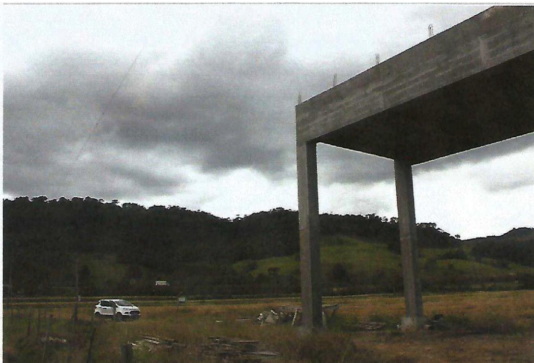
Figura 7 - Ponte Passo da Limeira: Etapa conforme Relatório de Progresso Meta 1, Letra A, B, C, D e E.
