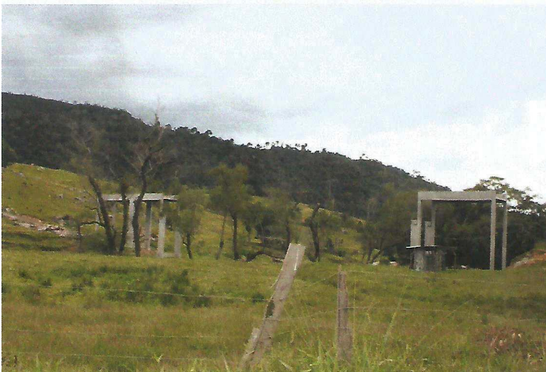
Figura 4 - Ponte São Wendelino: Etapa conforme Relatório de Progresso Meta 2, Letra A, B, C, D e E.
