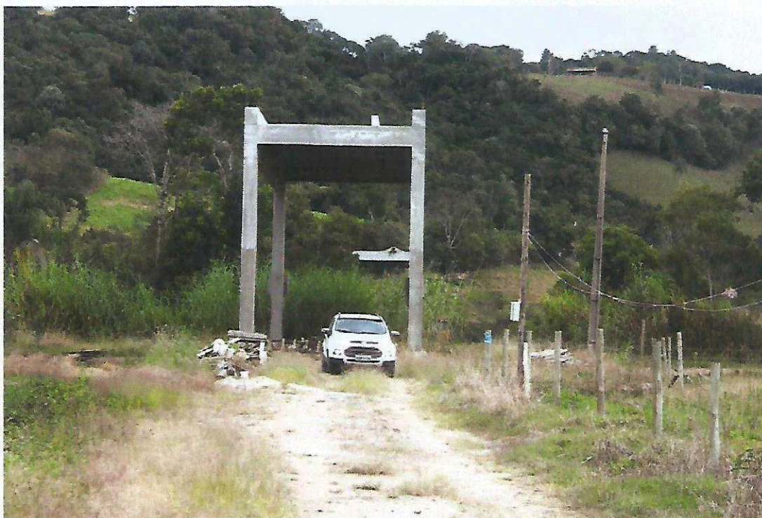
Figura 8 - Ponte Passo da Limeira: Etapa conforme Relatório de Progresso Meta 1, Letra A, B, C, D e E.
