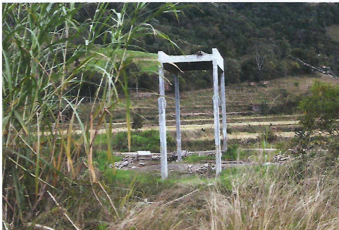
Figura 6 - Ponte Passo da Limeira: Etapa conforme Relatório de Progresso Meta 1, Letra A, B, C, D e E.
