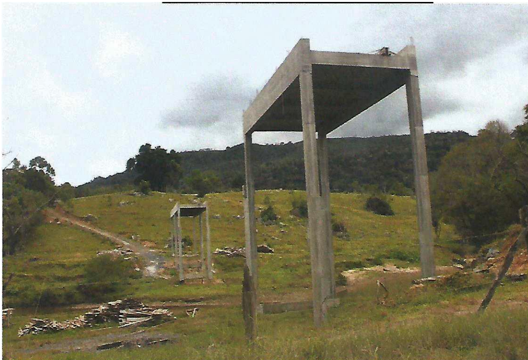
Figura 1- Ponte São Wendelino: Etapa conforme Relatório de Progresso Meta 2, Letra A, B, C, D e E.
